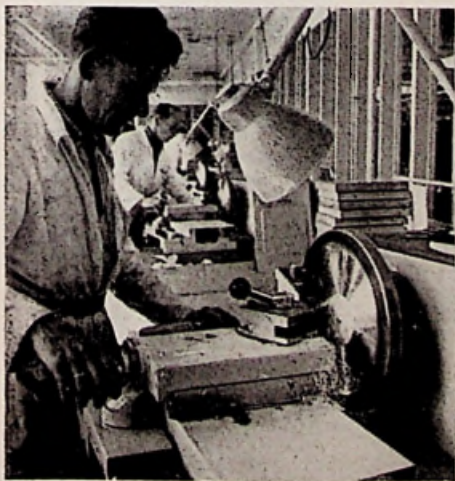
Fig. 64 - HET VLAKDRAAIEN van de achterzijde van de persmatrijs.
